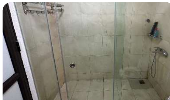
越南廠區_派駐宿舍浴室整改
