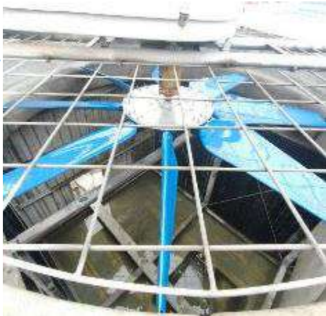
改造後：輕型FRP，葉片中空結構
