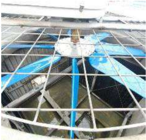
改造後：輕型FRP，葉片中空結構
